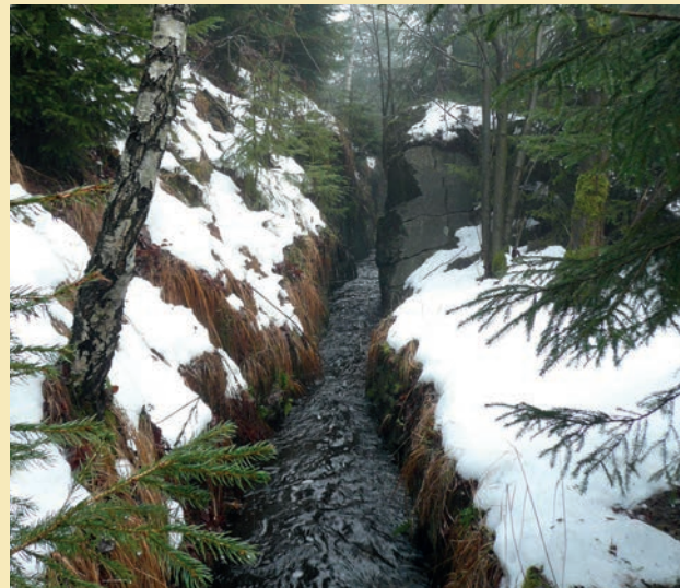
Der Grüne Graben im Erzgebirge (Sachsen) wurde im 17. Jahrhundert als Wasserzulauf angelegt, um damit mechanische Geräte in den Gruben des nahegelegenen Rohstoffabbaugebiets anzutreiben. Im Bild ist der in den Fels gehauene Grabenabschnitt nahe dem Nonnenfelsen zu sehen. Foto: Ch ivk, CC BY 3.0, via Wikimedia Commons
