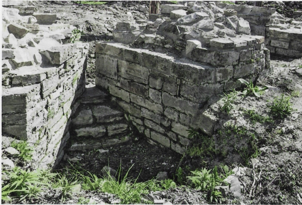
Abb. 3: Lichtschlitz mit abgetrepten Sohlen (Foto: Jochem Ottersbach, 2015)
